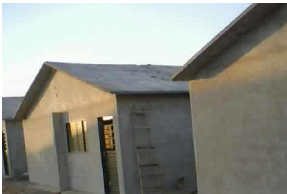
Figura 25 – Casa com estrutura do telhado utilizando sistema EcoLaje
