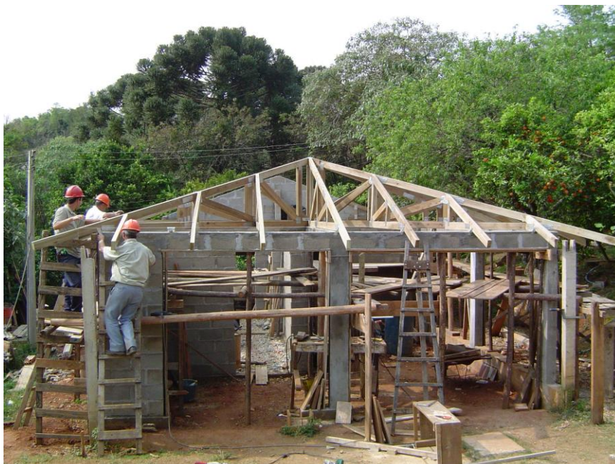
Figura 22 – Montagem de estrutura por operários
