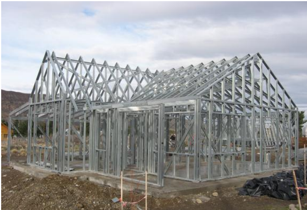
Figura 40 – Telhado de steel frame com tesouras
