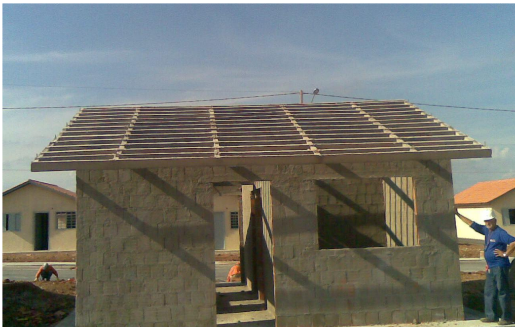
Figura 29 – Estrutura de telhado com sistema EcoTelhado
