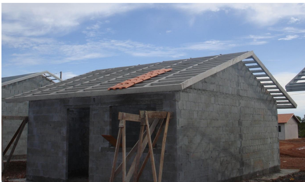
Figura 30 – Estrutura de telhado com sistema EcoTelhado
