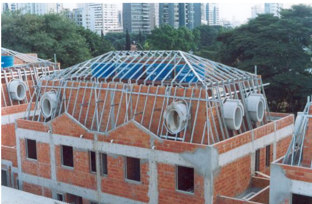
Figura 39 – Telhado de steel frame com caibros
