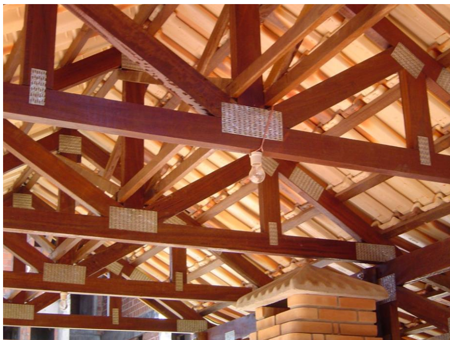
Figura 21 – Ligações entre peças com chapas de dentes estampados
