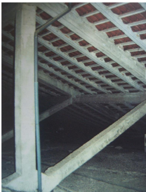
Figura 28 – Estrutura de telhado totalmente de concreto pré-moldado
