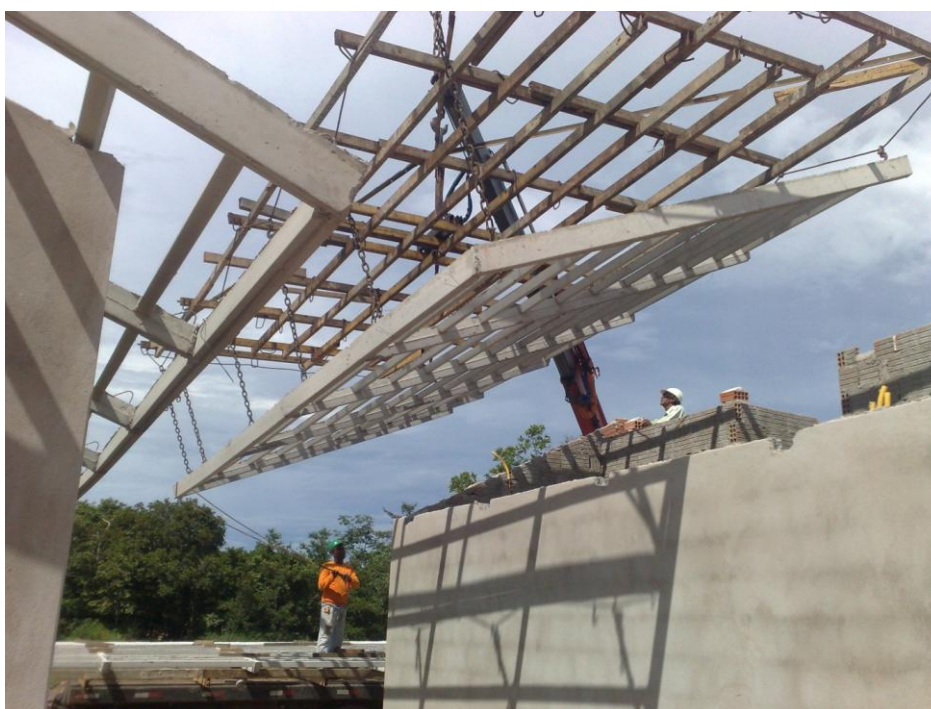
Figura 31 – Estrutura no sistema EcoTelhado içado por guindaste
