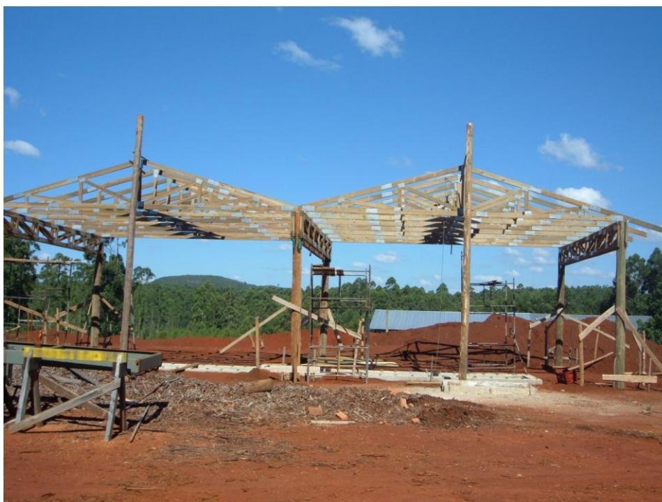
Figura 20 – Estrutura de telhado de grande vão com tesouras pré-fabricadas
