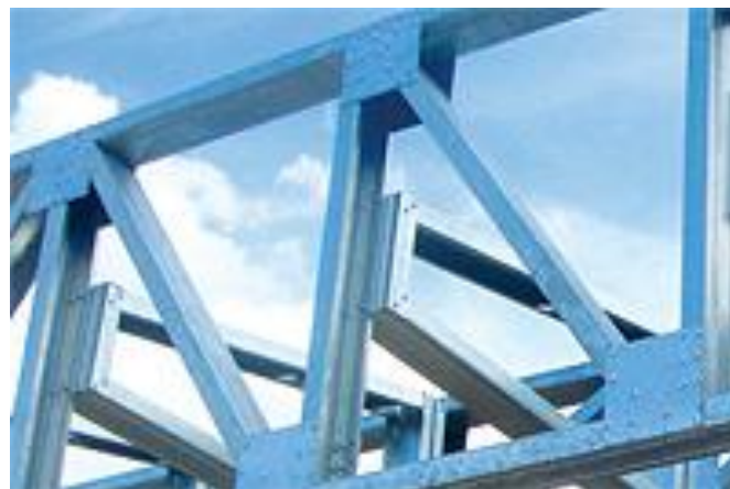
Figura 41 – Ligações de perfis com chapas Gusset
