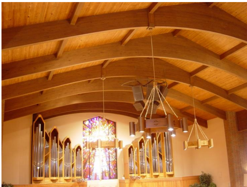
Figura 18 – Igreja com estrutura do telhado de madeira laminada colada
